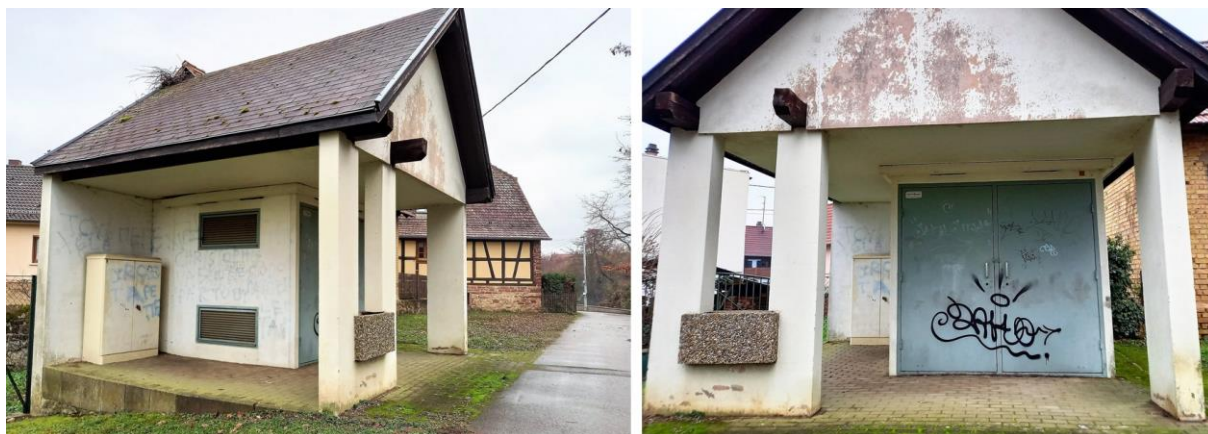
Le poste avant transformation
